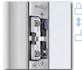
Die neue Tagesfalle Funktion (am Schließblech / Schließleiste)
